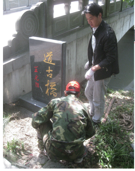
左图：道古桥地图（梁津铭绘）；右图：道古桥施工中
